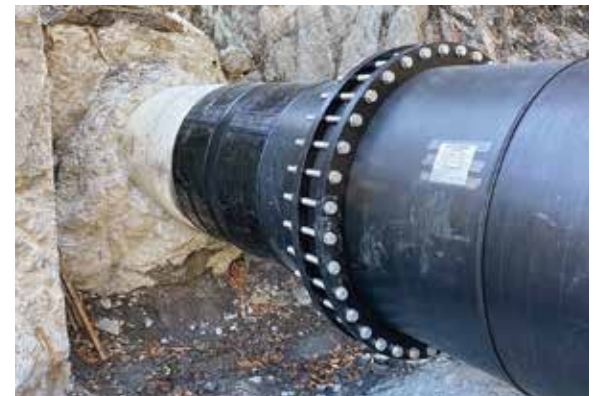
フランジ継手への加工品(鋼管との接続)
