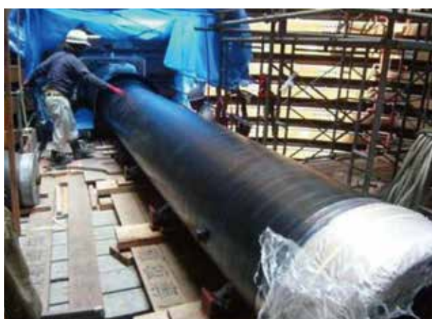
廃棄物処分場 導水管路
