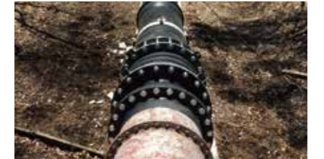
既設管との接続(フランジ接続)
