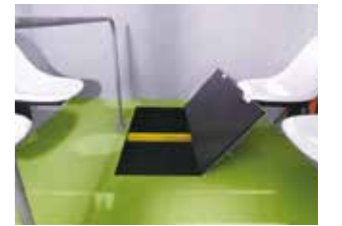
物資備蓄庫(床下部)
