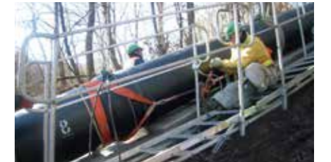
急傾斜地での施工
