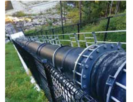
急傾斜地配管
