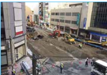
流動化処理土完了
