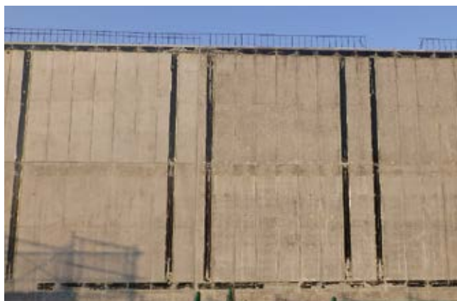
コンクリート打設後
