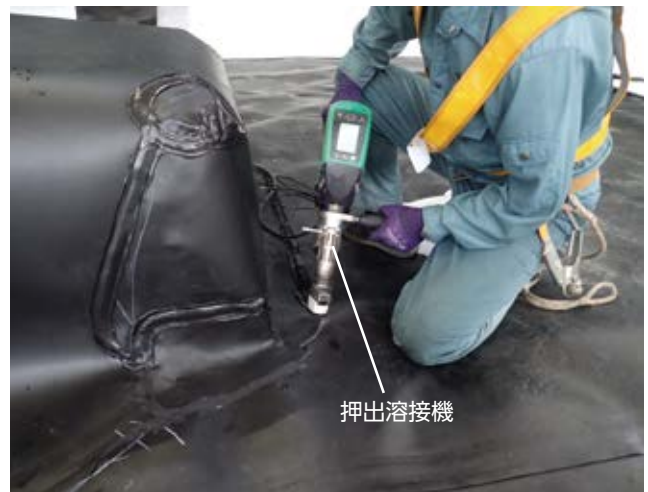
押出溶接機による溶接
