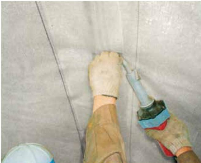
B：さらに、押し合わせ二重溶着した部分は、コンクリートの流れ方向に、熱風溶着機で、点溶着を行います。
