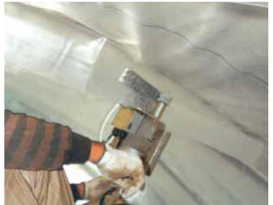
拌み合わせ溶着部を倒し手動式熱風溶着機を用いて溶着する。
