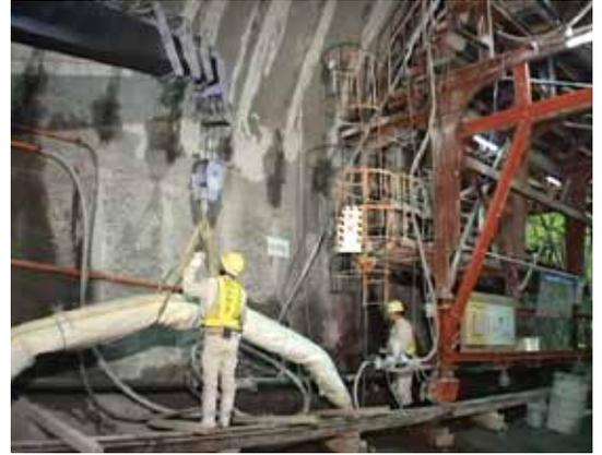
次シート防水材をシート型枠台車に広げた後、ラップ側の防水シート端部を20~30cm 折り返し、ラップ側不織布に穴を開け、注入口を設置する。
