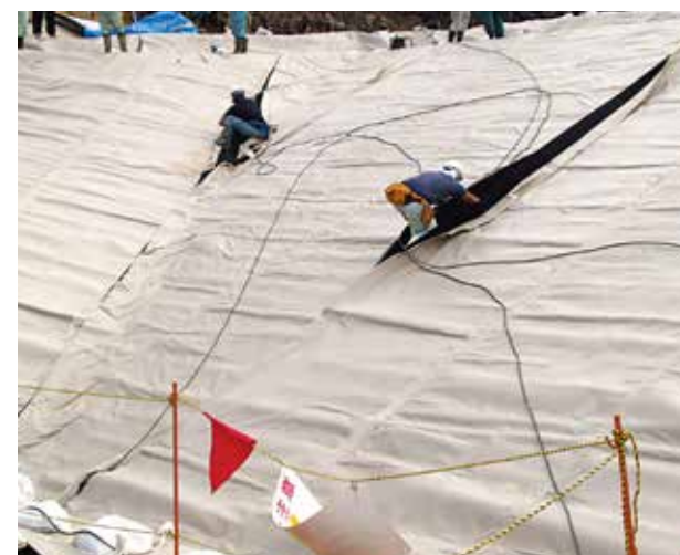
排水層敷設状況
