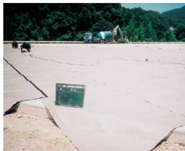
ガス排除層敷設状況
