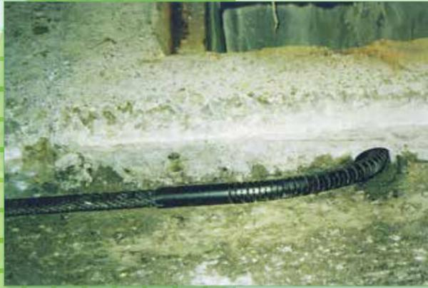
スルードレーンは、舗装体に浸透した雨水を速やかに排出し、滞留した雨水により基層や床版が劣化することを防止する耐熱性の樹脂製導水管です。
