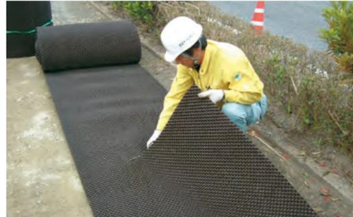
■ナクサを凹凸のない平らな場所で広げて、カッター・鋏により所定の長さに切断します。
