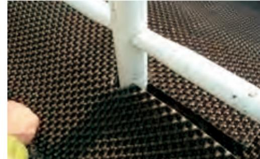
■ガードパイプ用穴あけ、スリット入れをカッター・鋏等で行います。ホールソーを使用するとさらに簡単です。ガードパイプ周辺は、コーキング材処理を行い、スリット部には上から「ナクサ」を被せ、周辺にアンカーピンを打ちます(パッチあて)。
