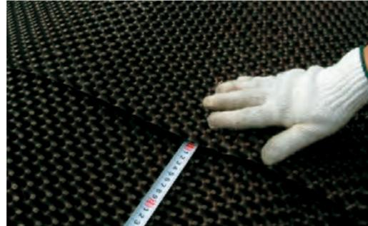
■エンボス凸部がざらついている方を表にして敷設してください。重ね合わせ部は瓦積み状になるように、エンボス同士を重ね合わせ敷設します。(標準重ね代は10cmです)
