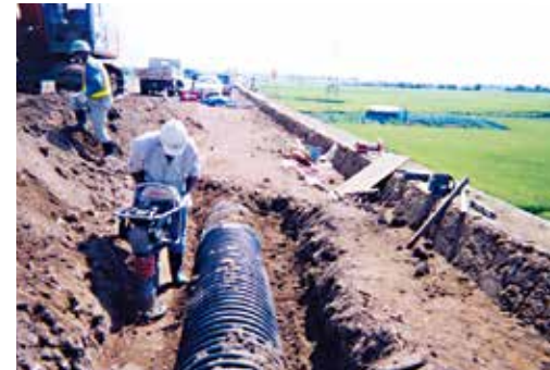
農地排水工事
