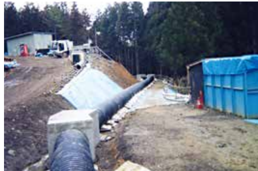
迂回水路工事
