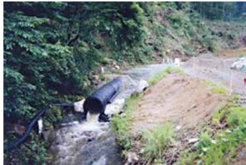
暗渠排水工事
