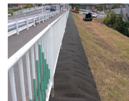
国土交通省 国道246号(神奈川県)
