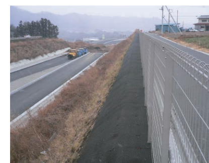
国土交通省 国道17号(群馬県)
