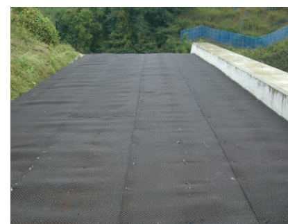
西日本高速道路(株) 阪和道(和歌山県)
