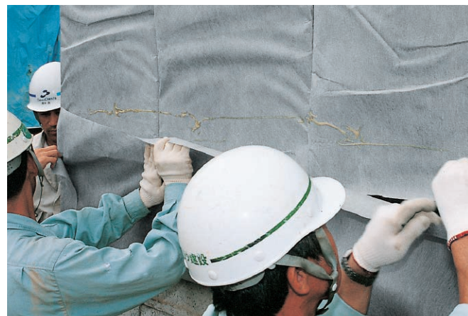
グリ・シートKP12-600とグリ・シートKP12-300のフィルターを接着剤で張付けます。
