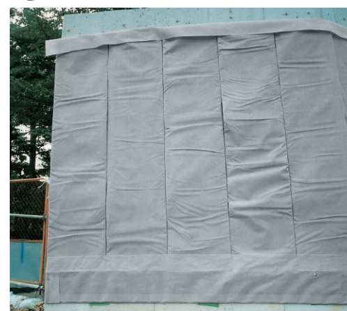
グリ・シートKPタイプを擁壁に張付けて3時間の養生後、なるべく早く裏込め土を埋め戻してください。
