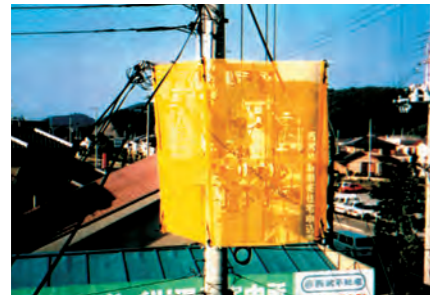
トランスカバー 作業員の感電防止
